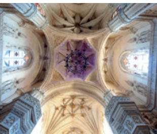
Monasterio de San Juan de los Reyes. Detalle de las bóvedas / Monastery of San Juan de los Reyes. Detail of vaults.
