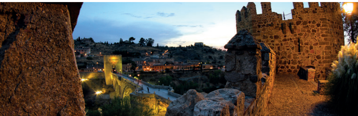
Puente San Martín / San Martín Bridge.
