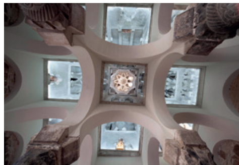
Mezquita del Cristo de la Luz. Bóvedas. / Mosque of Cristo de la Luz. Vaults..
