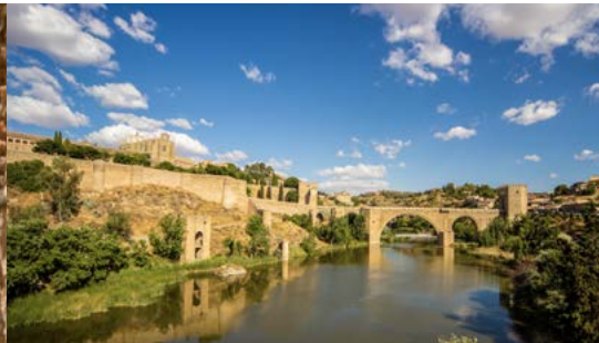
Vista parcial de la judería: muralla, Torre de la Cava, Puente de San Martín y Monasterio de San Juan de los Reyes
